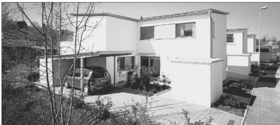
Das erste LBS-Systemhaus im Neubaugebiet „Auf Berken“ in der Tuttlinger Nordstadt kann am Sonntag von 11 bis 16 Uhr besichtigt werden. Foto: pm
