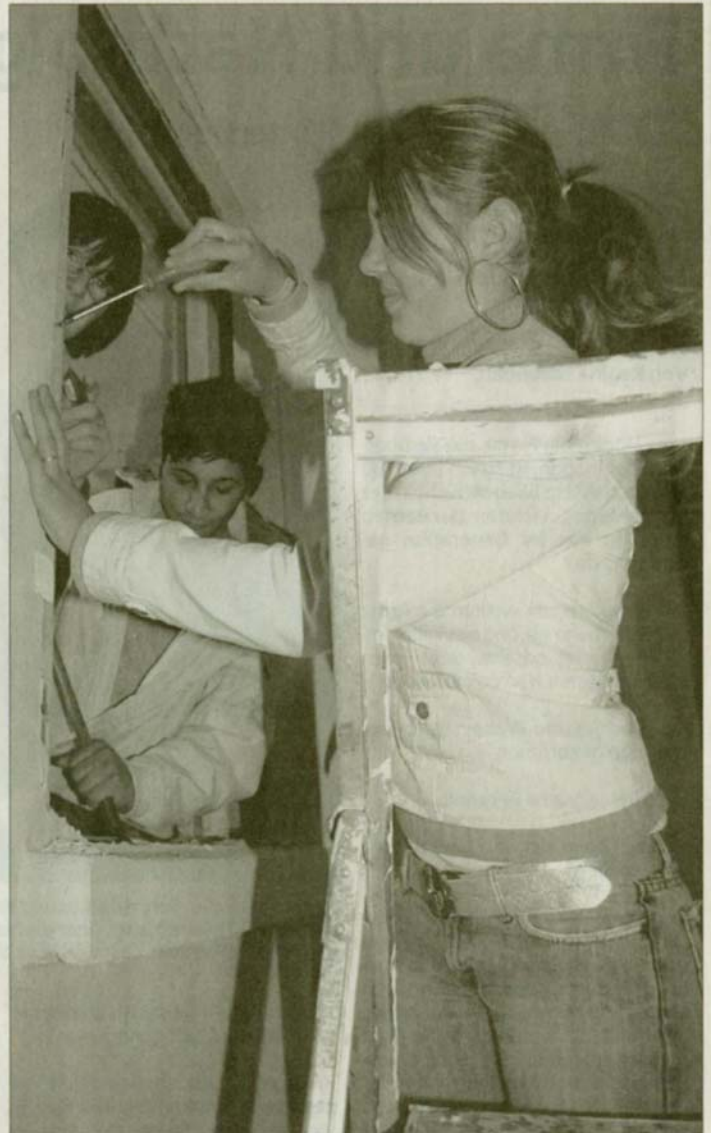
Mit großem Einsatz halfen gestern Schülerinnen und Schüler aus der Solwegschule bei den Renovierungsarbeiten im zukünftigen Tafelladen.
