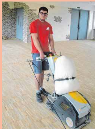
Geschäftsführer Steffen Herrmann packt mit an - hier beim Abschleifen des Parketts.
